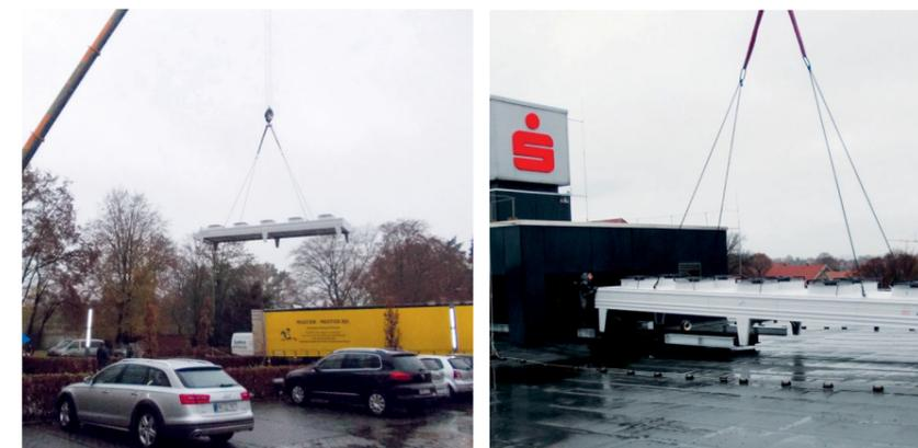
Montage eines neuen Klimageräts auf dem Dach der Hauptstelle in Lüdighausen
